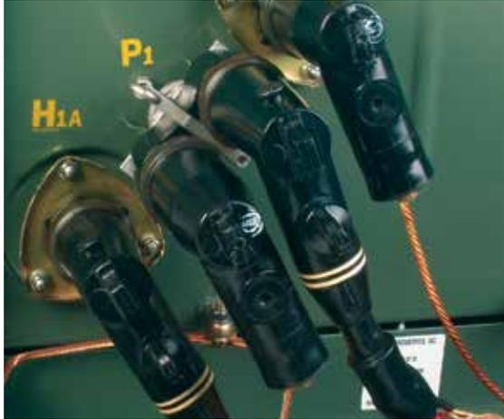
Deux parasurtenseurs coudés et un traversée intermédiaire. Cette méthode fait uniquement appel à des parasurtenseurs coudés. (L'un des parasurtenseurs coudés peut être monté sur le raccord H1A, si la procédure opérationnelle le permet.)
