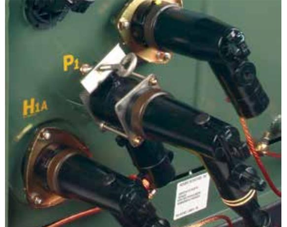
Parasurtenseur coudé et parasurtenseur à support à manchon. Cette méthode permet de réduire l'encombrement en éliminant la traversée intermédiaire. C'est préférable, p. ex., avec un transformateur sur mini-socle.
