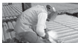
Chantiers de construction
