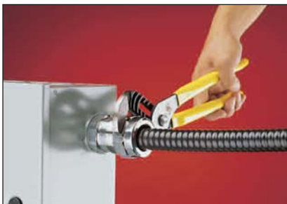
3. Resserrer l'écrou du presse-étoupe.
