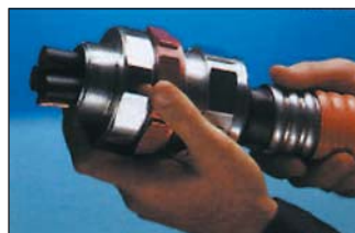
2. Installer le raccord Star Teck XP md sur le câble
