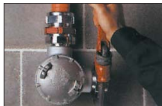
5. Poser le manchon sur le boîtier
