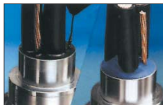
4. Remplir de composé obturateur (pâte ou liquide)
