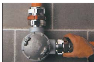
6. Insérer le câble et resserrer l'écrou d'accouplement rouge
