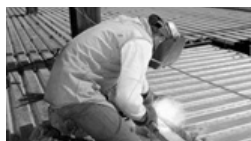
Chantiers de construction
