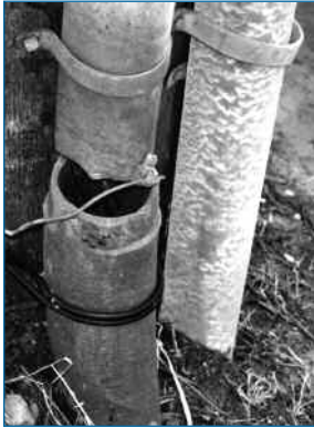
Les brides de retenue en acier (U) doivent être mises à la terre et n'ont pas de bout évasé.
