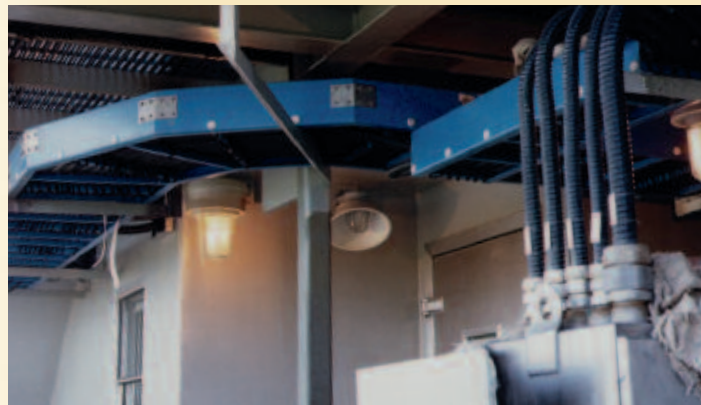
Chemin horizontal suspendu avec descente vers la machinerie.
